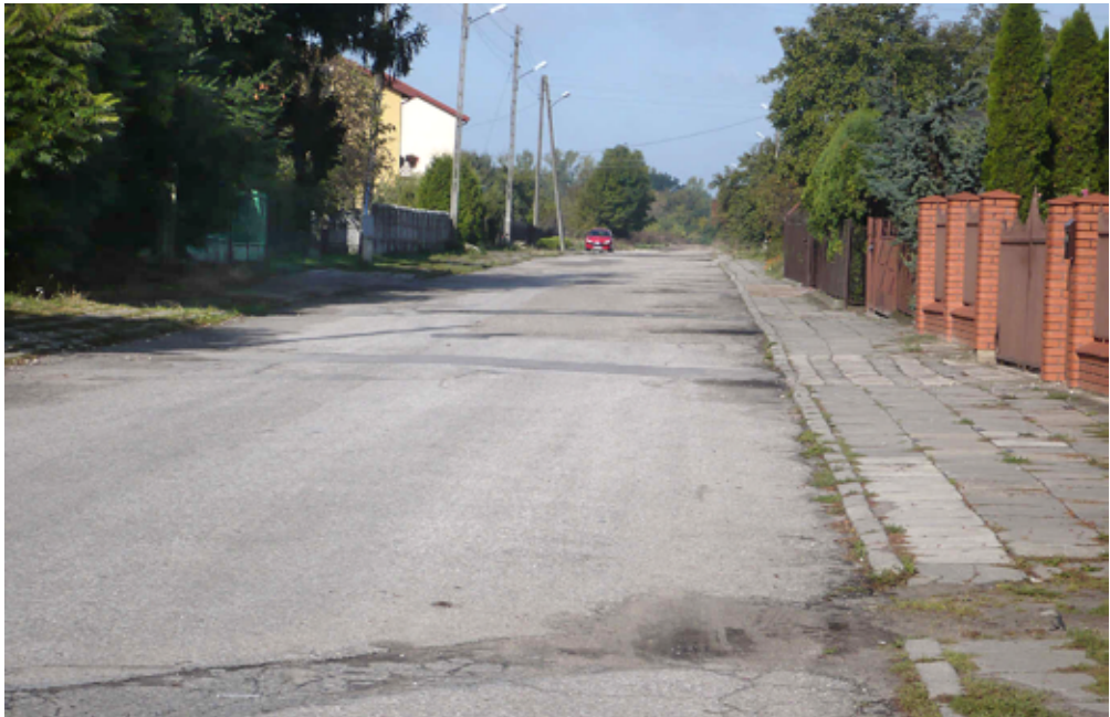
Chodniki przed modernizacją
