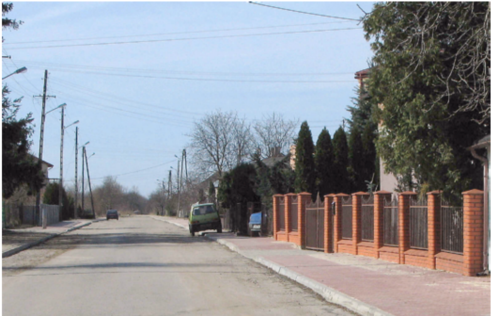
Chodniki po modernizacji
