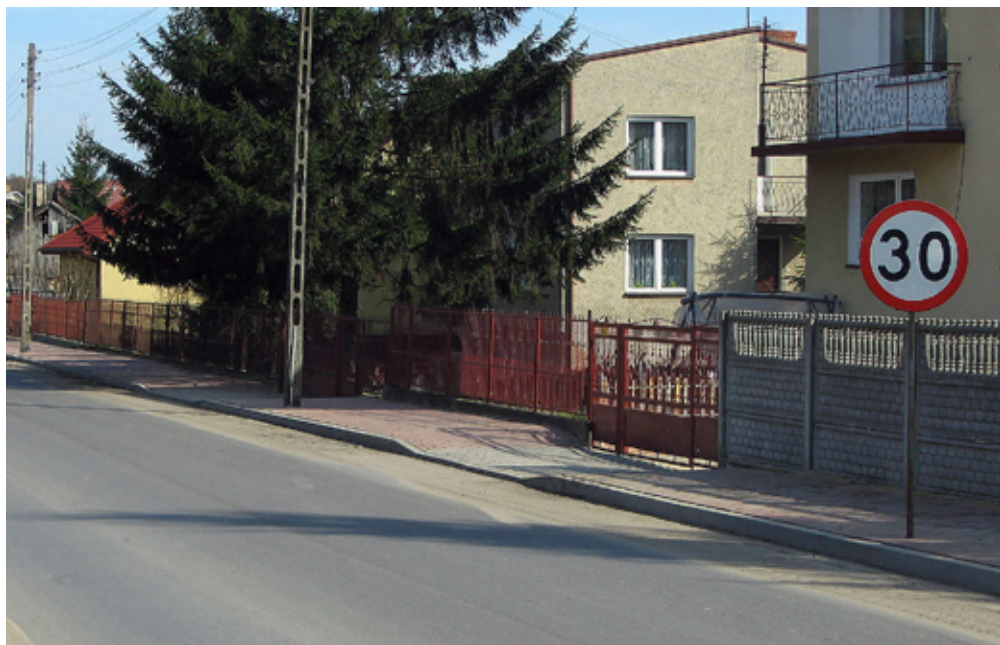
Chodniki po modernizacji
