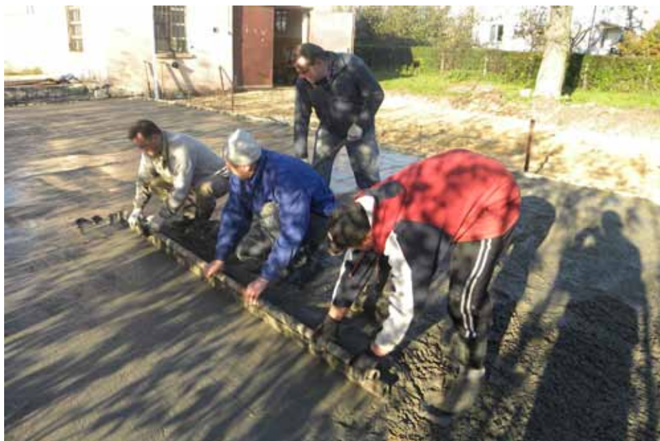
Szadłowice – kolektywna praca przy budowie placu
