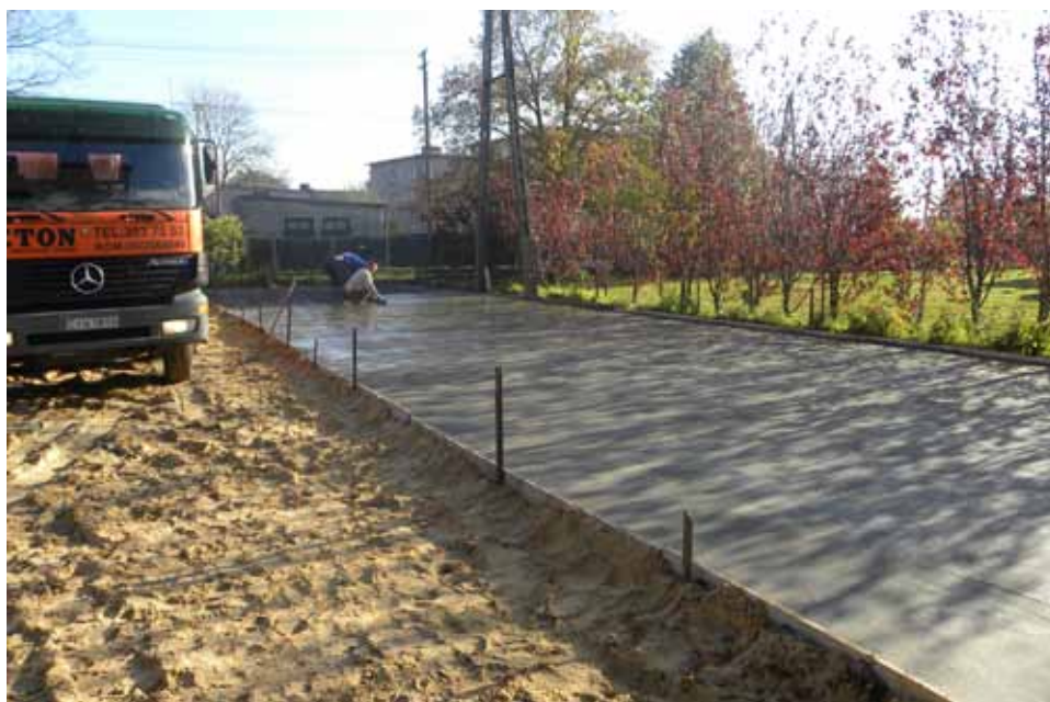
Szadłowice – dla wykonania placu zakupiono beton przygotowywany w wytwórni
