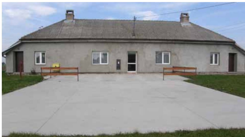
Przyborowo – zagospodarowanie terenu wokół świetlicy i odnowienie elewacji
